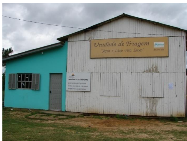
Figura 05: Vista frontal da Unidade de Transbordo.
