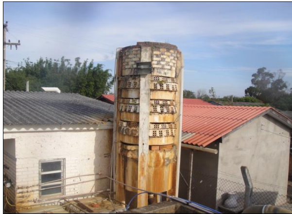
Figura 13 Floculador onde é adicionado sulfato de alumínio
