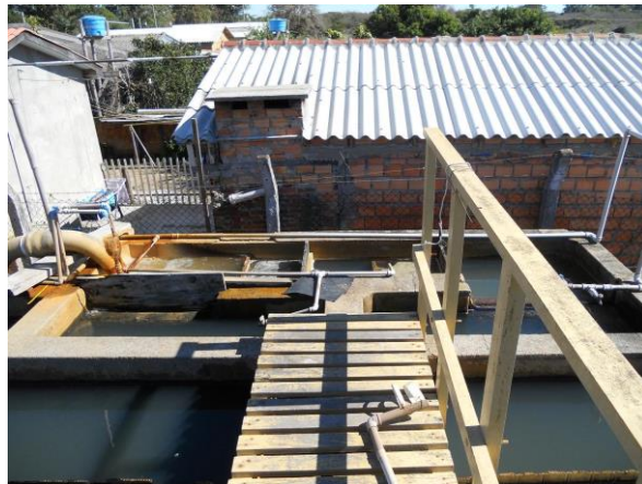
Figura 13 Floculador onde é adicionado sulfato de alumínio
