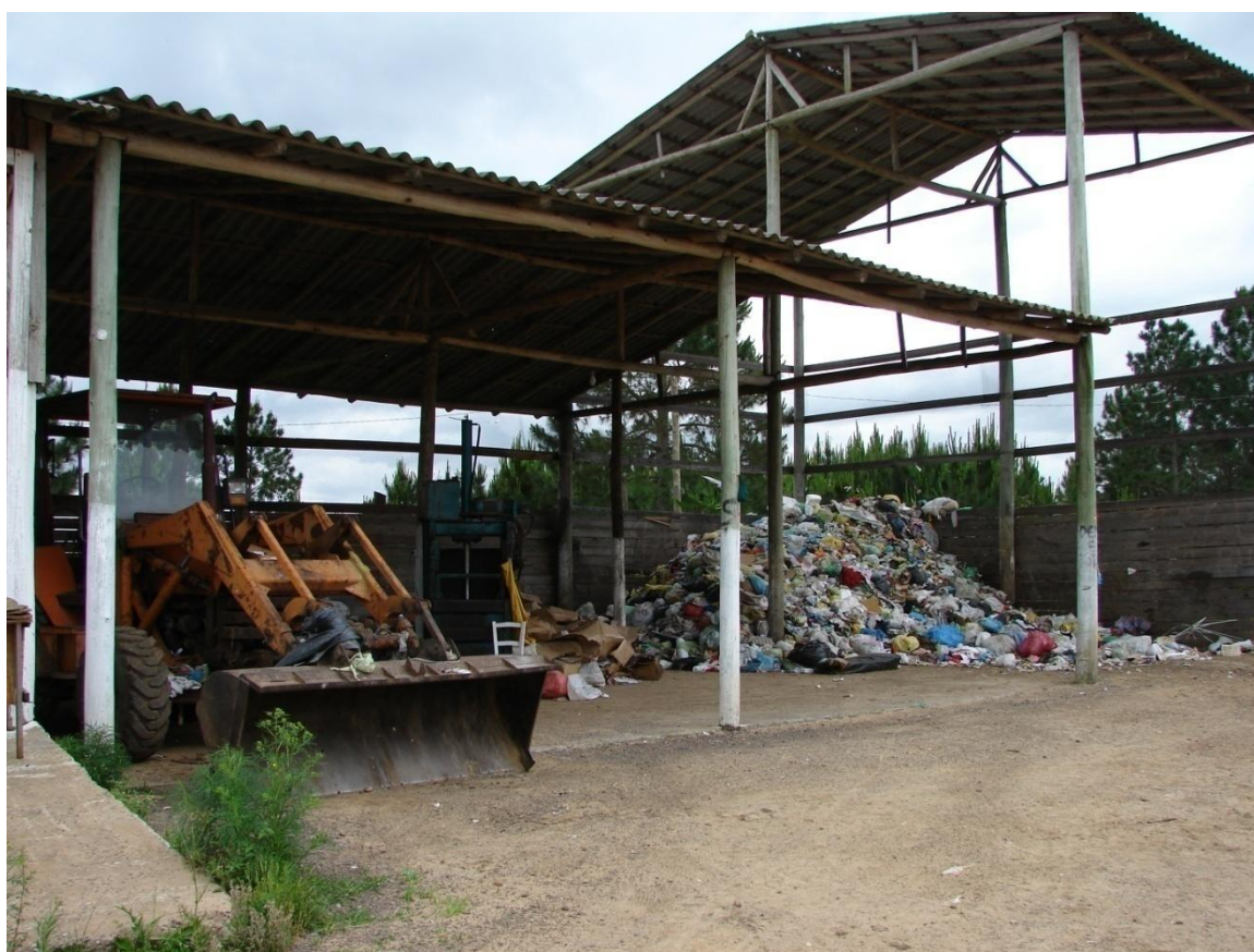
Figura 06: Vista da disposição de resíduos
