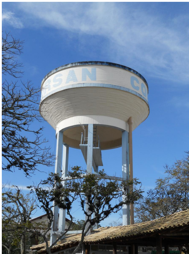
Figura 10 Reservatório R-2 (elevado) com capacidade de 100m 3
