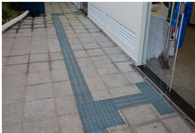
Figura 6 - Imagem de referência de instalação de piso tátil de borracha
