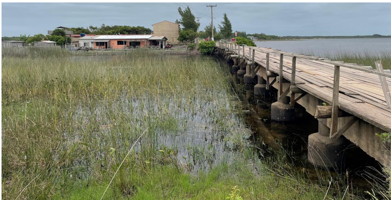
Foto 2: vista geral da ponte.
