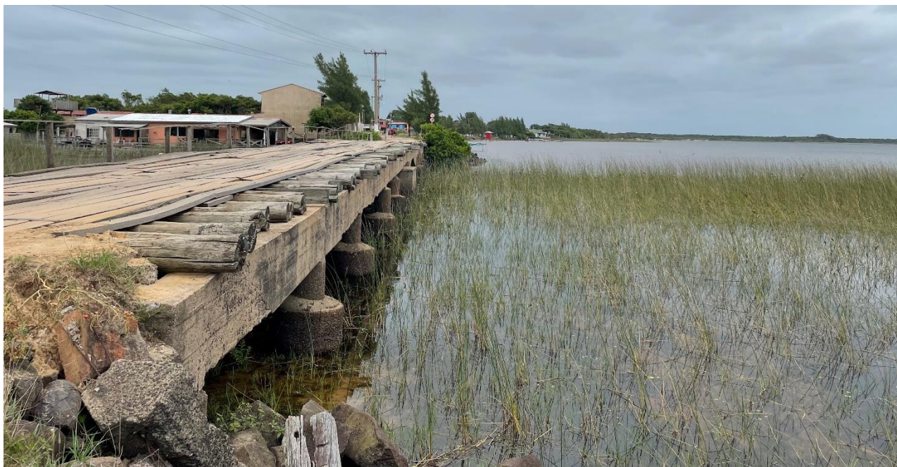
Foto 1: vista geral da ponte.
