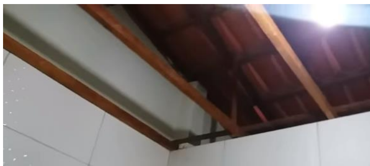
Figura 5 - Imagem ilustrativa barroteamento forro de PVC.
