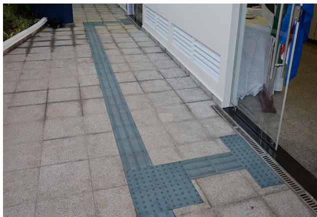
Figura 8 - Imagem de referência de instalação de piso tátil de borracha
